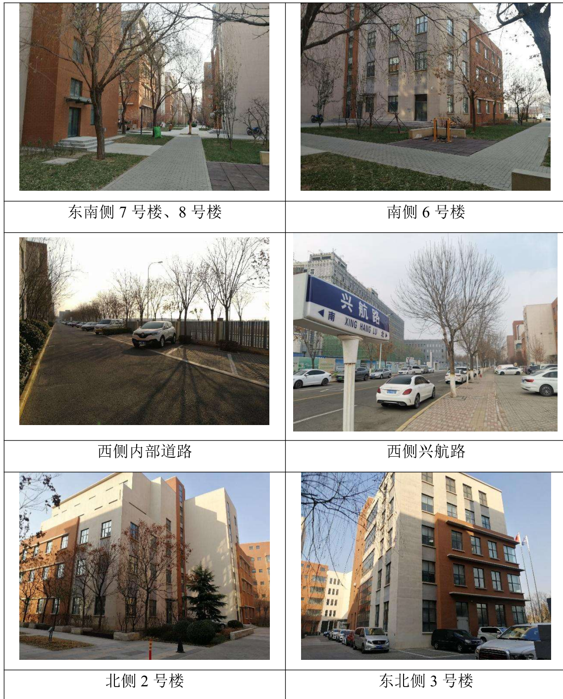
图 2.1-1 本项目选址及四至情况的实景照片
